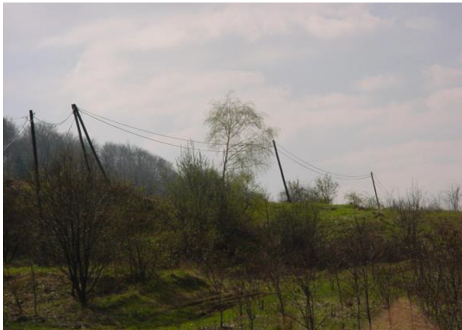
Fot. 2. Przechylone słupy na skutek osuwania terenu na Bielance
