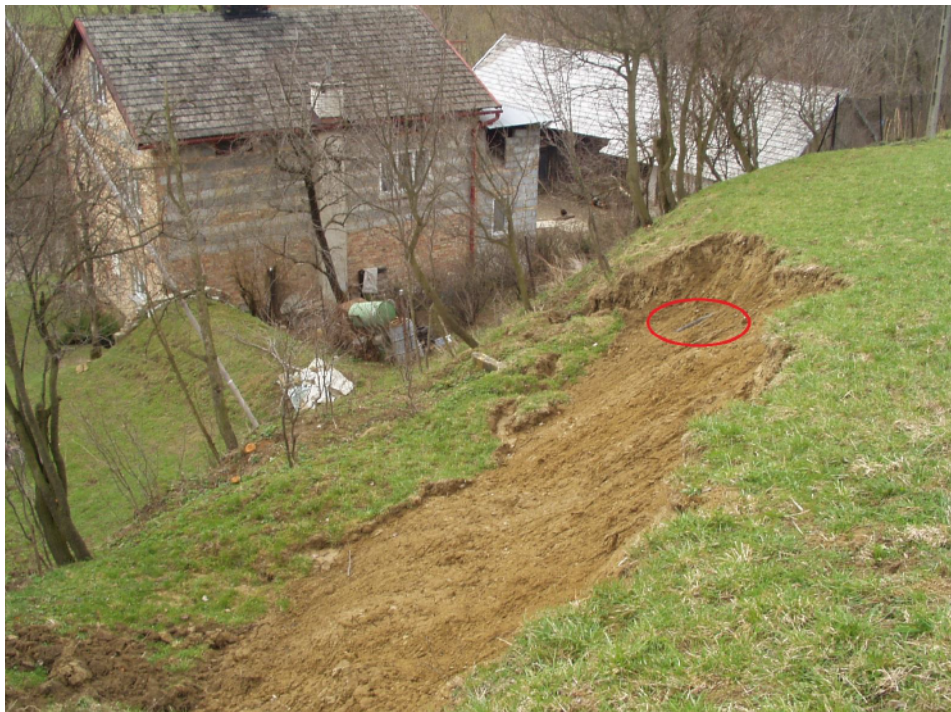
Fot. 3. Odslonięcie rur gazowych w wyniku ruchów osuwiskowych
