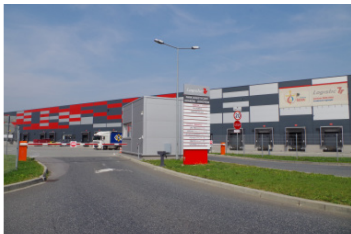
Fot. 4. Park logistyczny „Kraków-Kokotów” w WSAG
