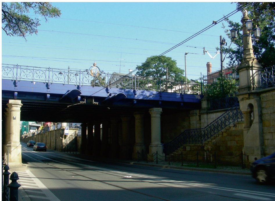
Fot. 2. Most (wiadukt) kolejowy nad ul. Lubicz z murami oporowymi (fot. J. Kukulak)
