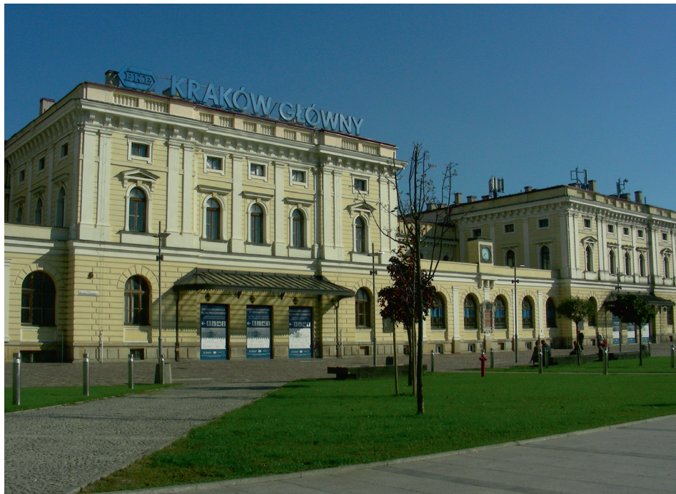
Fot. 1. Budynek dawnego dworca PKP Kraków Główny (fot. J. Kukulak)
