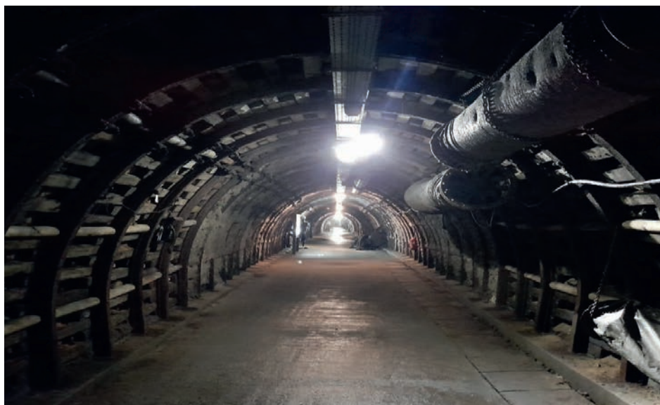
Fot. 3. Trasa podziemna w Parku Wielokulturowym Stara Kopalnia – Centrum Nauki i Sztuki
